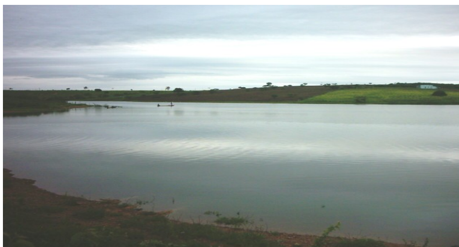
Fotografia 2: Vista parcial do Açude de Ribeirópolis-SE. (Wesley Lima)
