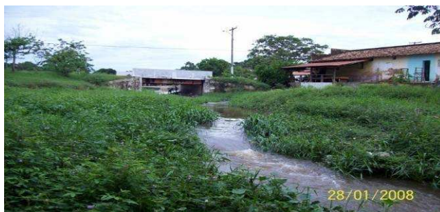
FOTO 12: Riacho Ponte – fonte de abastecimento d’água do bairro Ponte em estado de degradação.
