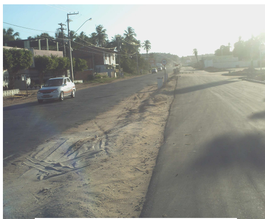
Figura 4 – Obras de duplicação da Rodovia João Bebe Água
