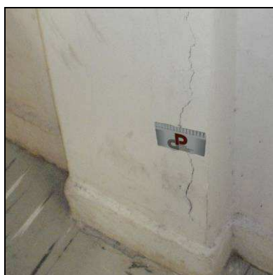
Figura 23: Medição de trincas e fissuras com o fissurômetro
