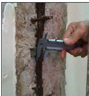
Figura 24: Medição das armaduras
