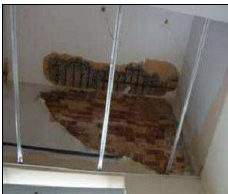
Figura 17: Laje do pavimento superior vista de baixo.
