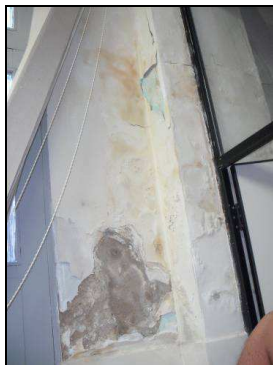
Figura 6: Entrada da Sala 02.
