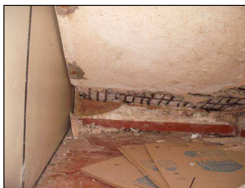
Figura 18: Escada vista do depósito.
