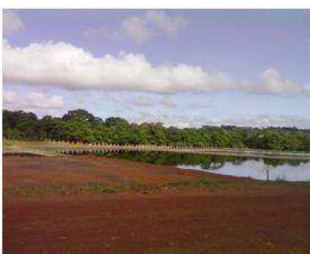
Foto 4: Lagoa de tratamento de chorume
