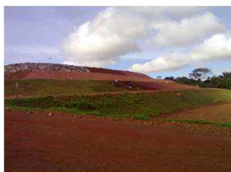
Foto 7: Plantio de grama no talude
