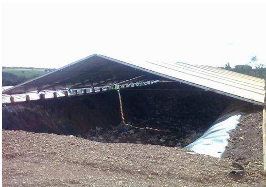
Foto 10: Vala de resíduos, dos serviços de saúde na área de disposição. Fonte: Leitão, G.C (2011).
