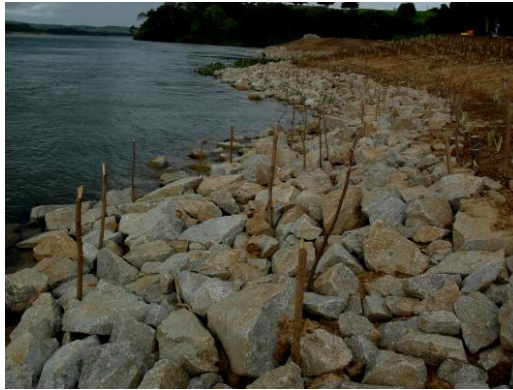
Figura 2: Enrocamento vegetado na base do talude com estacas de sabiá no experimento 1.
