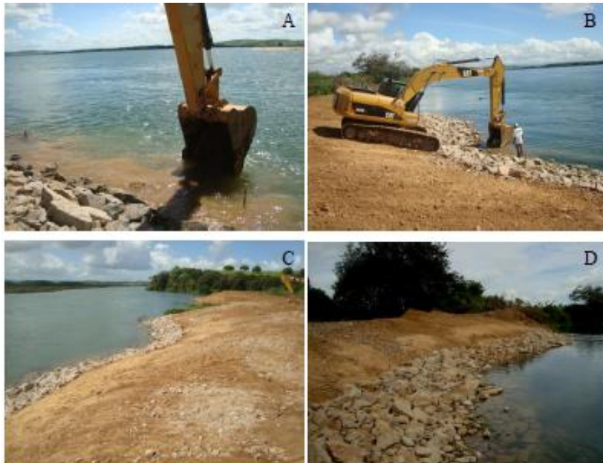
Figura 1: Enrocamento da base do talude na área de implantação do projeto, (A, B) Colocação de pedras (diâmetro 0,70 m) abaixo do nível da água e (C, D) operação de enrocamento realizada no experimento 1.
