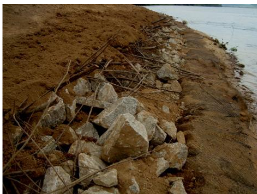
Figura 4: Construção da parede enrocada na base do talude na área de implantação do projeto no experimento 2.
